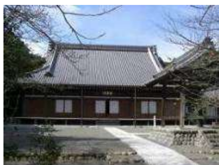
修復された本堂。
